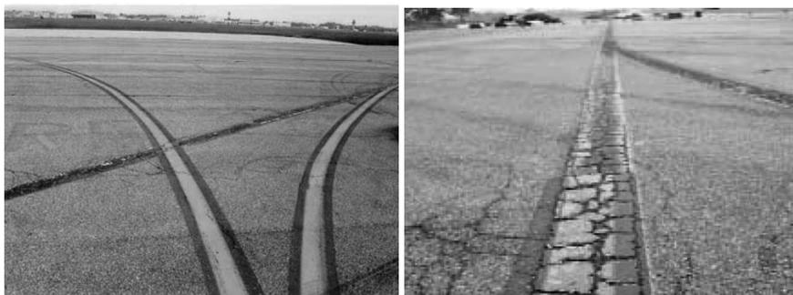
Рис. 6. Состояние разметки рулежных дорожек
