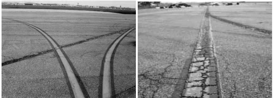
Рис. 6. Состояние разметки рулежных дорожек
