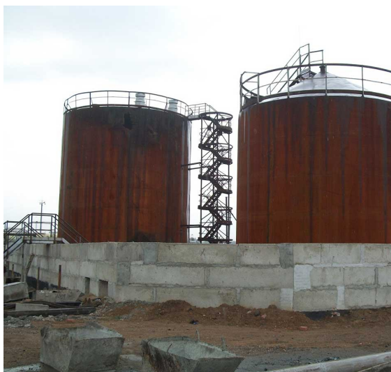
Рис. 4.1 Коррозия резервуаров
