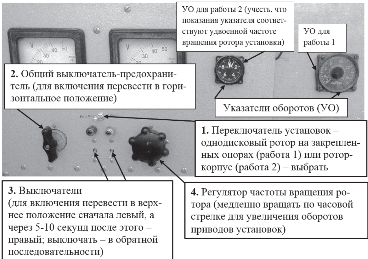
Рис. 10. Вид панели управления общей системы привода электроустановок с переключателями, установленными в положении “выключено” и порядок работы с системой привода
