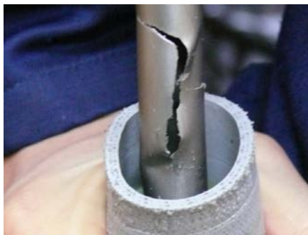
Рис. 4. Разрушение трубопровода системы водоснабжения
