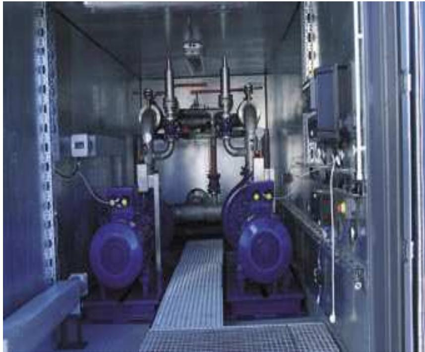
Рис. 15 Насосная станция в арктическом исполнении для эксплуатации в Сибири
