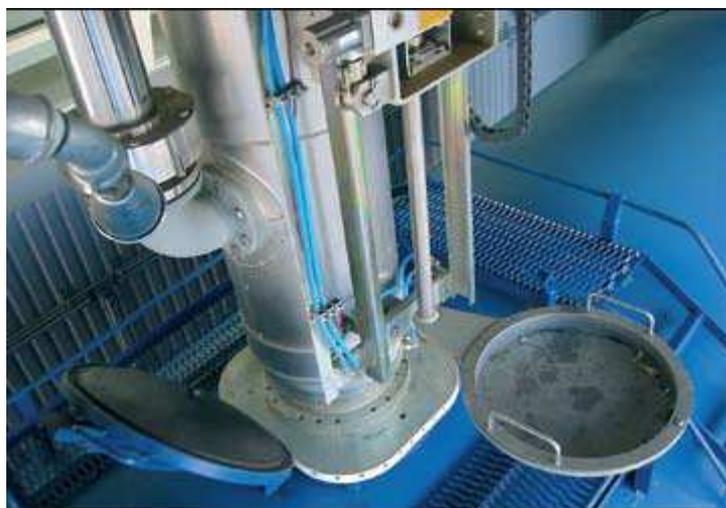
Рис. 41 Наливная труба с системой отведения паров
