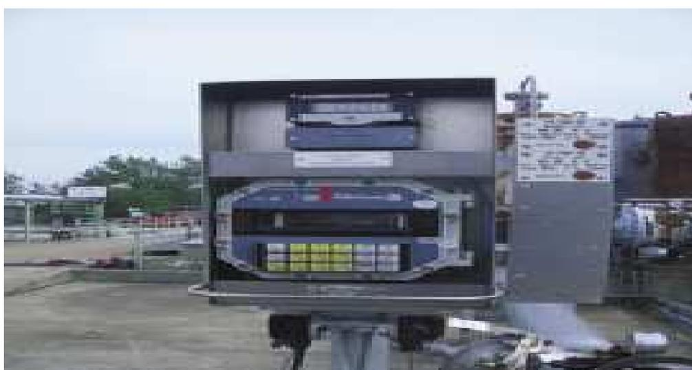
Рис. 24 Рабочая станция оператора пункта налива.
