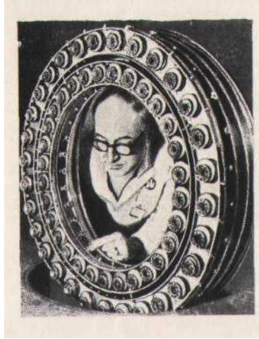
Рис.9. Топливные коллекторы форсунок камеры сгорания американской фирмы Дженерал Электрик: - верхнее кольцо – дежурная зона; - внутреннее кольцо – основная зона
